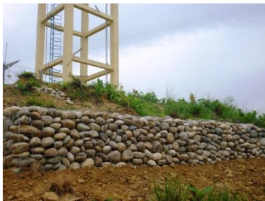
Jordskredssikring af Indrabasti vandtårn
